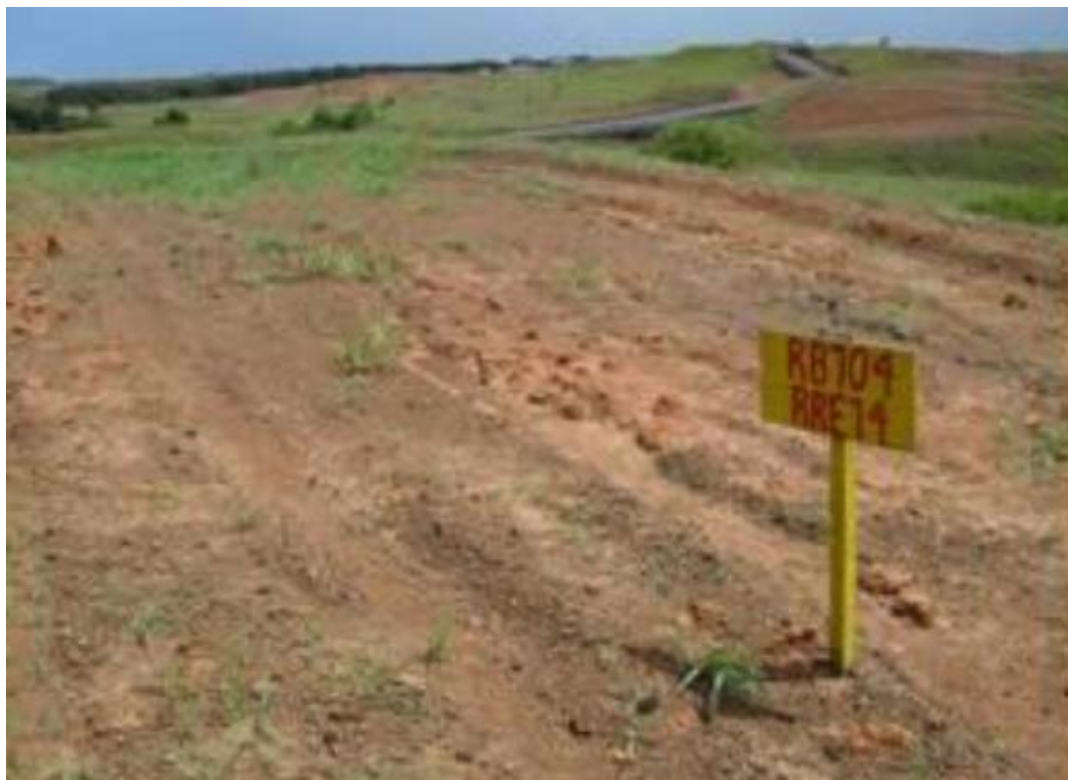
Figura 5. Evaluación de emergencia área con plintita expuesta (20 días)
