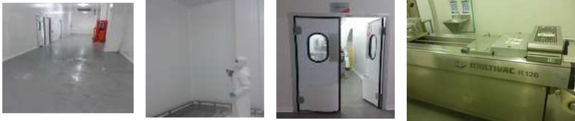
Figura 5. Los pisos no son porosos, las paredes son blancas, puertas con ventanas y maquinas en acero inoxidable, todos estos factores facilitan la limpieza y permite la iluminación de instalaciones internas
