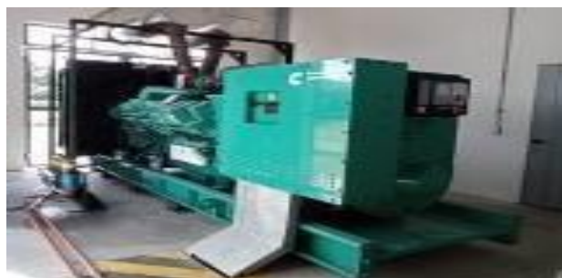
Figura 3. Generador Cummins 1250 kva.
